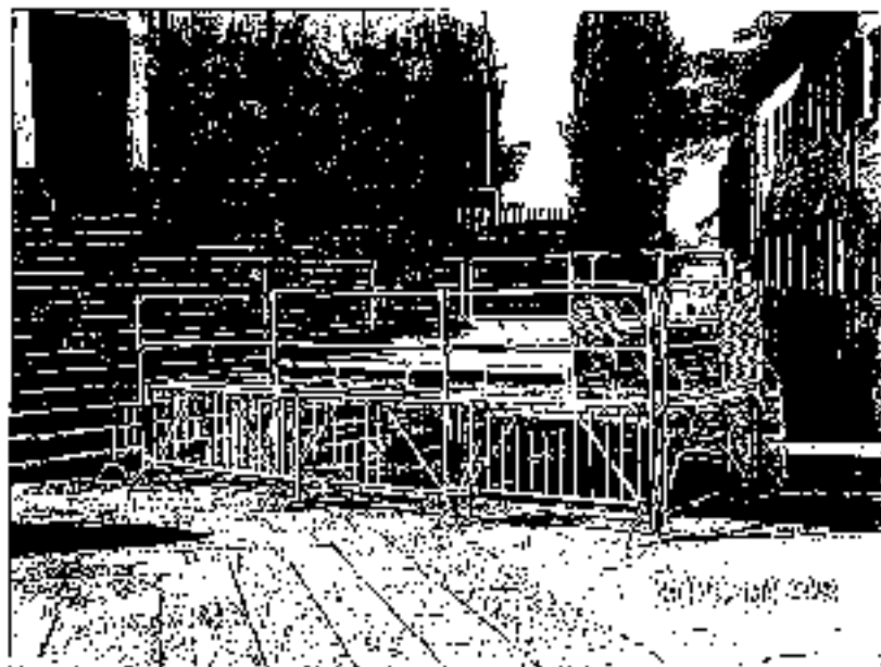
Figura 1 tribuna realizzata per sovrapposizione del palco con le piccole pedane marittime
