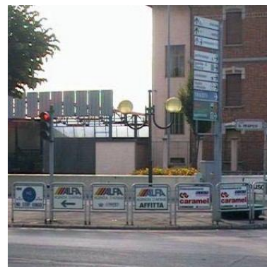
Impianti abbinati a transenne parapedonali
